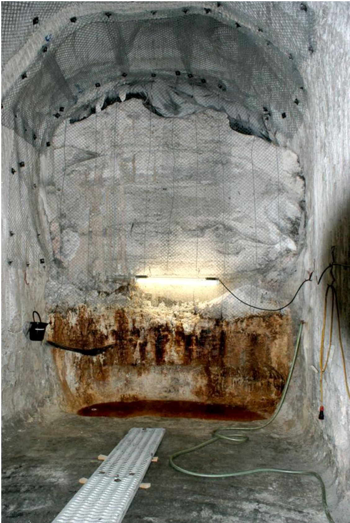
Abbildung 2 - Laugensumpf vor Abbaukammer 9/750 (Lösungsstelle P750006). (Foto R. Krupp, 14.07.2016)
